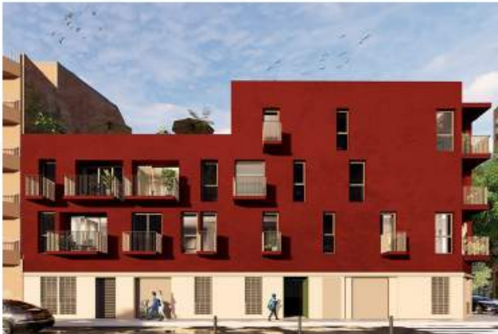
Vista exterior desde el paso peatonal, fachada sur-oeste.
