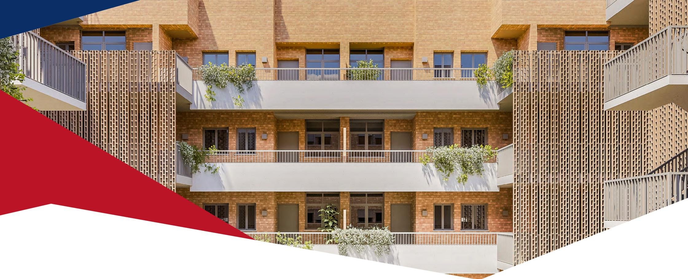
La configuración de las fachadas del edificio se realiza según el grado de exposición que presentan, intenso y sólido hacia Camino de Ronda y más ligero y traslúcido hacia el patio interior, siempre apostando por materiales duraderos que requieren poco mantenimiento, combinando ladrillo cara vista, mortero de cal y hormigón.
