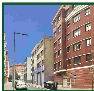
Doctor Entrecanales, 4 previo al derribo del Pabellón Industrial
