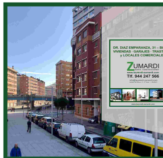
Doctor Díaz Empananza, 31 previo al derribo del Pabellón Industrial
