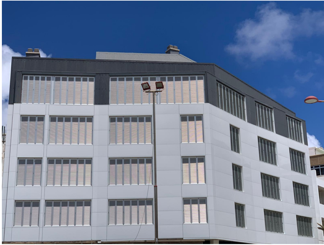
Edificio Plaza del Pilar Plaza del Pilar 4, C/Lepanto35 y C/Castillejos 44
