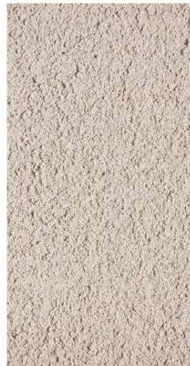
Fachada Mortero Tirolesa + Pintura Color Arena
