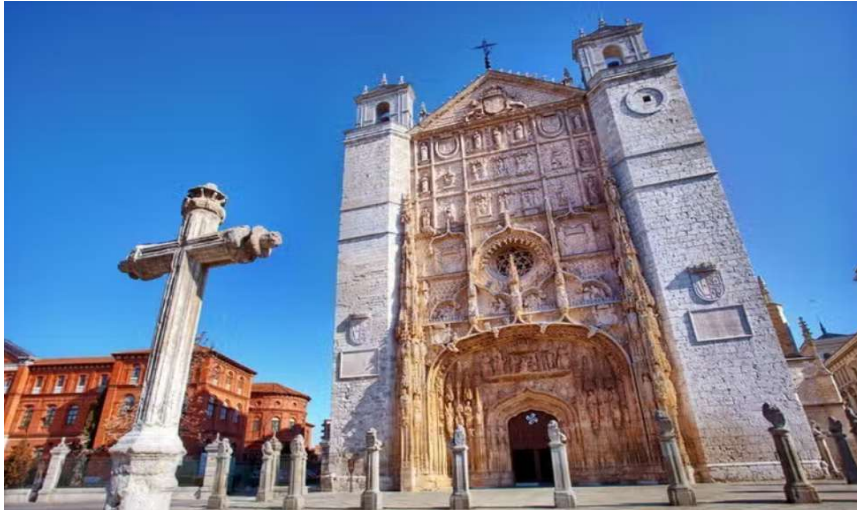
Fachada de San Pablo
