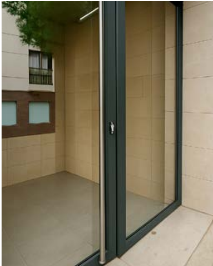
Puerta exterior. De acero laminado lacado en frío y vidrio de seguridad.
