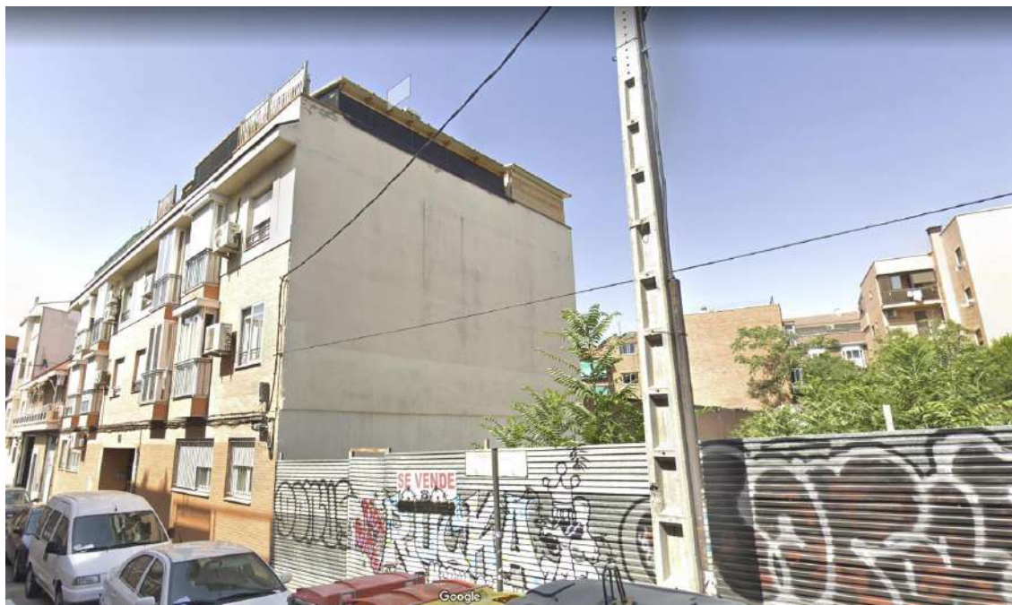
1 Medianera sur con vivienda Miguel Mayor 16
