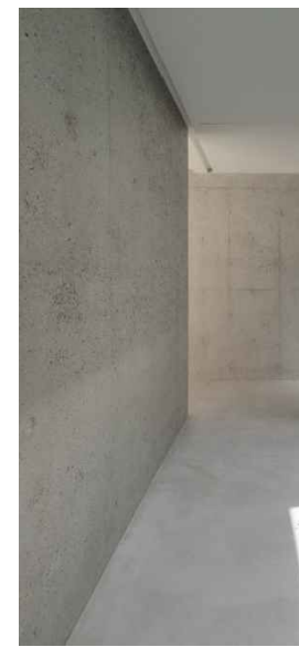
Imatge ref. paviment planta -1 amb formigó fratassat, polit i pintat amb 2 capes pintura acrílica en fase aquosa i parets formigó vist .
