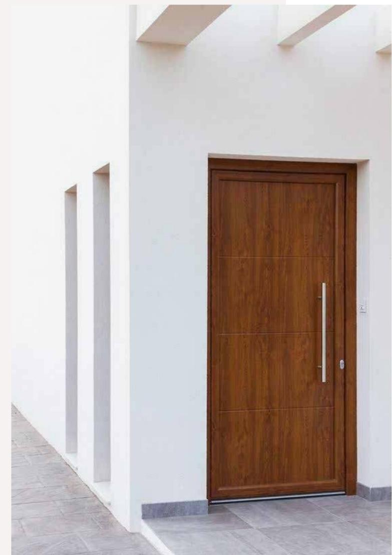
Puerta blindada en acceso a vivienda con herrajes de seguridad, tirador exterior y mirilla óptica.
