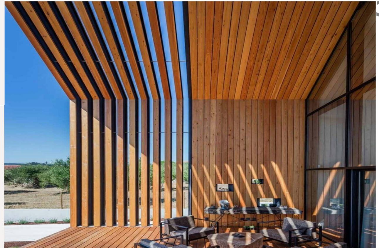
Sistema de celosías fijas de aluminio con acabados de madera lacada tipo brise-soleil.
