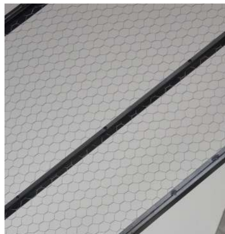
Pletinas pintadas + malla seguridad
