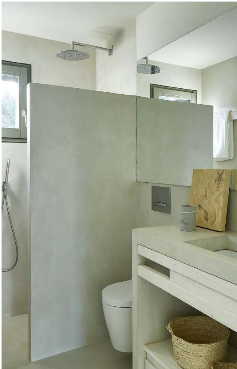
Mampara de obra
