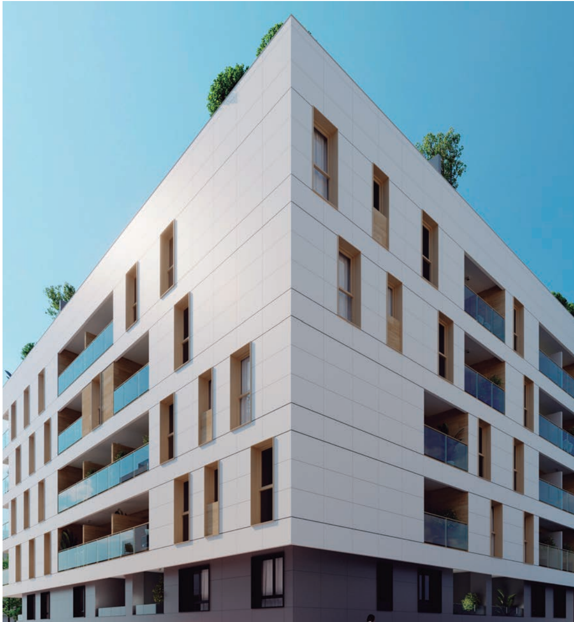
Vista fachada del edificio
