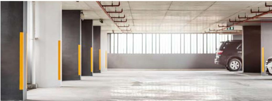
Solería de garaje de hormigón pulido, y rayado en rampas.
