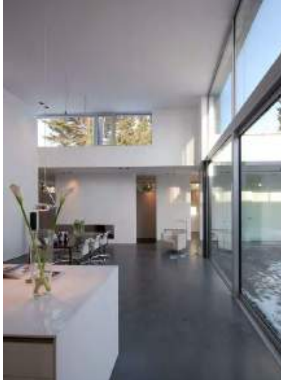
Pavimento Slurry Slurry screed
